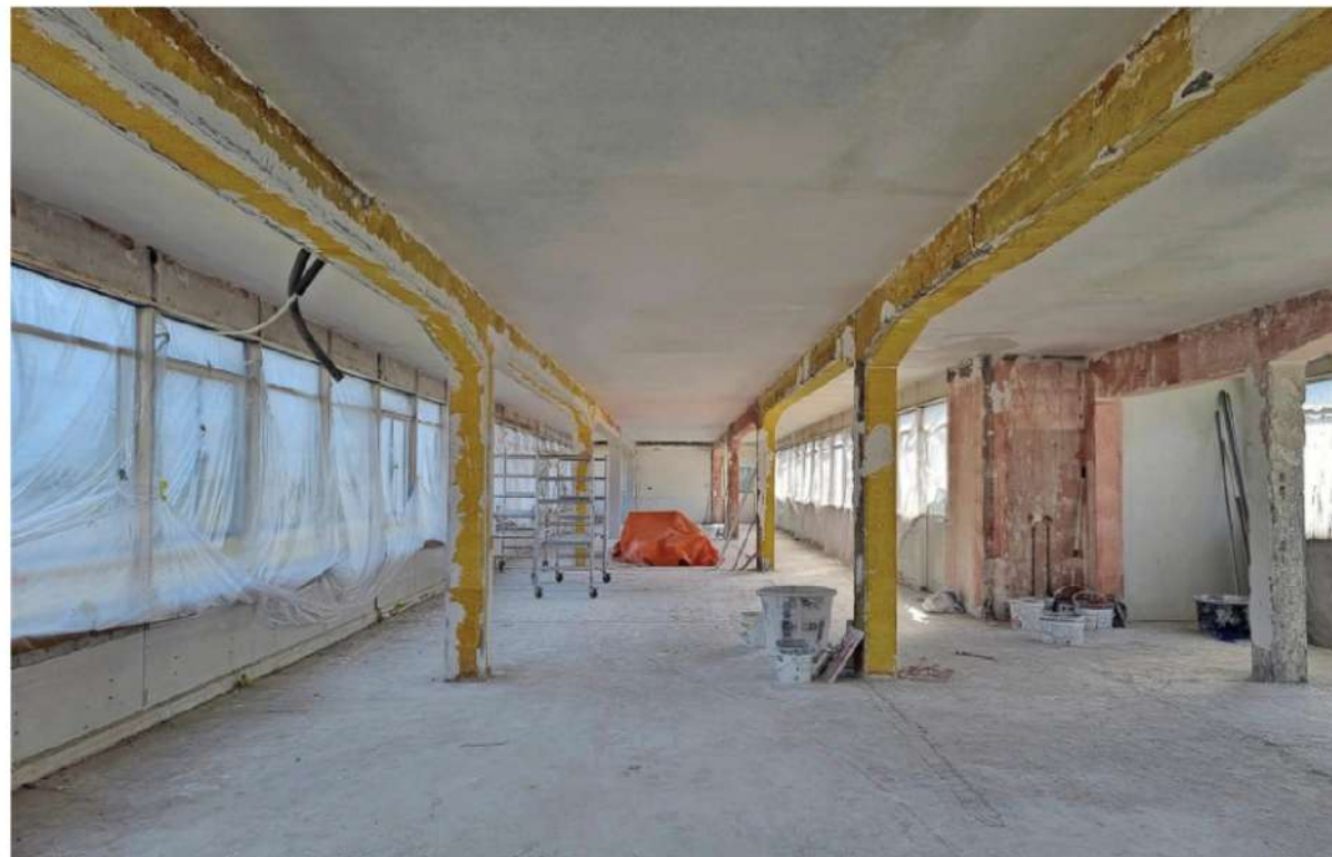
De - blijkbaar 'illegale' - sloop van de binnenwanden van het Ter Meulenpaviljoen.
