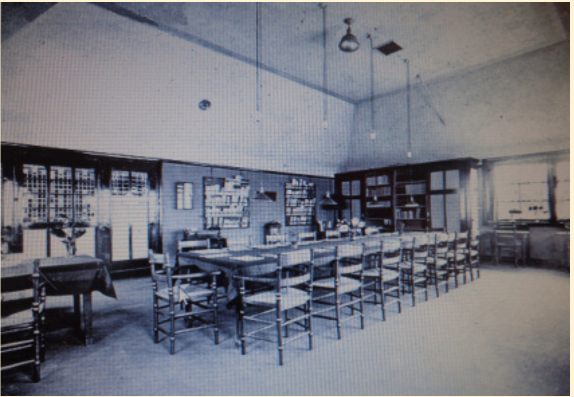
Leeszaal van de Openbare Christelijke Bibliotheek en Leeszaal in het Boazhuis aan de Havenstraat, 1913. (foto Oud Hilversum en Omstreken).
