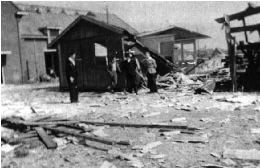
Op het terrein van Bruil werd zware schade aangericht. Deze houten loods lijkt ernstig te lijden hebben gehad van raketvuur. In de restanten van de garage geheel rechts werd de blindganger gevonden. (coll. Joop Reijnders)
