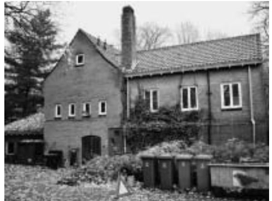
Het huidige aangezicht van de Wisseloordbunker.
