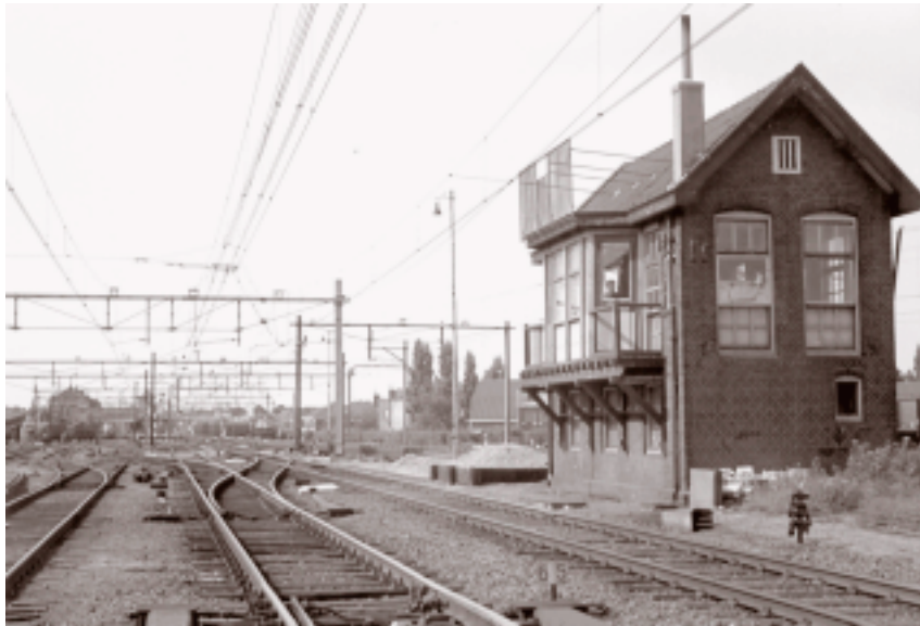
Hilversum, 25 juli 1958. Post 3 lag in de splitsing van de spoorlijnen naar Baarn (Amersfoort) en Blauwkapel (Utrecht). Ook deze post werd door het invoeren van een centrale verkeersleiding (in post T, naast de grote spoorbomen) overbodig en is gesloopt. (foto: J.G.C. van de Meene, Zwolle)
