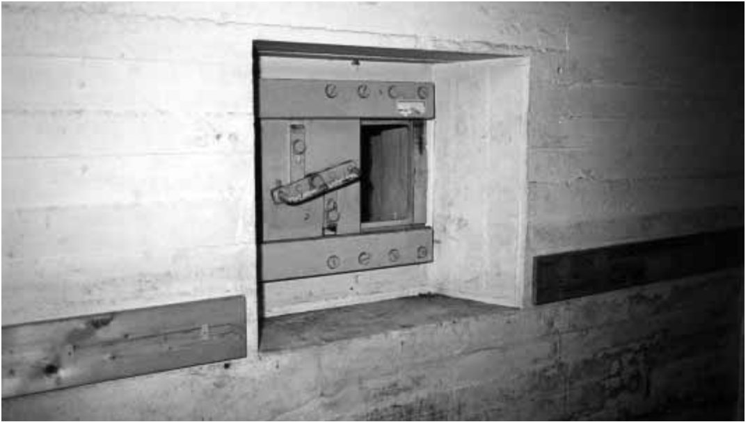
De in de bunkerwand aangebrachte schietgaten geven een indruk van de degelijkheid van het bouwwerk. De 1 1/2 meter dikke wanden bleken tijdens luchtaanvallen eind 1944 bestand tegen voltreffers met raketten (foto: EJP).
