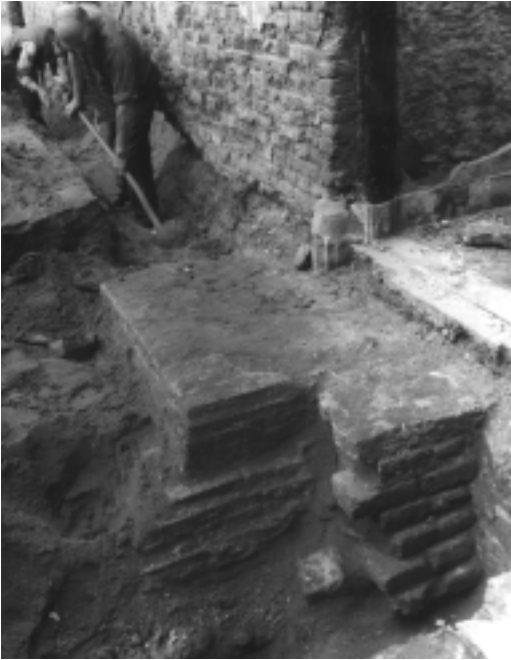
Opgravingen bij de Grote Kerk in 1973. Bij de oude ingang onder de toren aan de Oude Torenstraat zijn de funderingsresten van kloostermoppen zichtbaar die onderdeel waren van de kerk die in of kort na 1416 daar gebouwd is. (Coll. Goois Museum)
