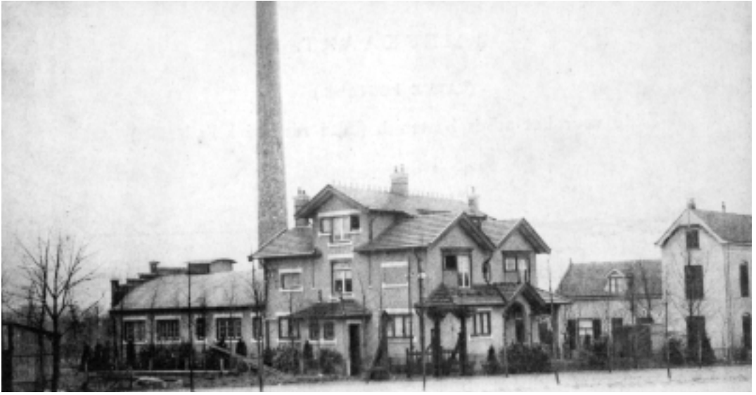
De "Electrische Fabriek" op een prentbriefkaart uit ca. 1905. Duidelijk is te zien dat het ketelhuis en machinekamer een halfroond dak hadden (Coll. Goois Museum).
