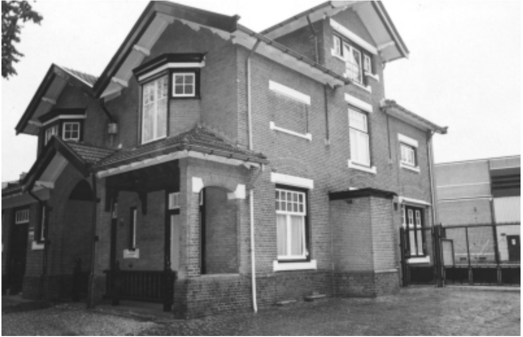
De westgevel van de centrale in 1996. Goed te zien is dat de achterste helft van de centrale gesloopt is om plaats te maken voor het nieuwe transformatorhuis op de achtergrond. Het voorste gedeelte is nog in originele staat (Foto: auteur).
