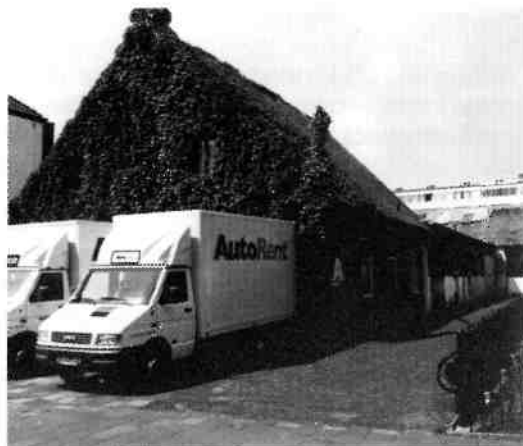
De boerderij Langstraat 48. Het dak van de vroegere stal is onlangs gesloopt en door een platte afdekking vervangen (foto E.J. Pelgrim).
