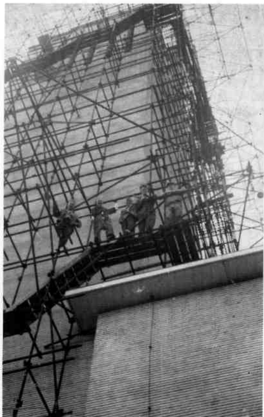
Afb. 2. De bouw van de steigers om de raadhuistoren. Links de heer Baas (foto: C. Baas).
