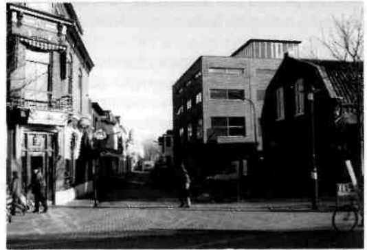
Een nieuw kantoorpand in de Spoorstraat (notabene een architectenbureau) staat hier duidelijk niet op z'n plaats.
