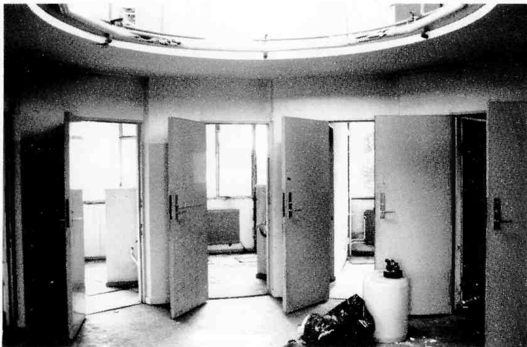
De kamertjes in het Dienstbodenhuis waren erg functioneel. Als men binnenkwam bevond zich aan de rechterhand een wastafel en aan de linkerhand een ingebouwde kast. Verder het kamertje inlopend opent de ruimte zich naar buiten toe, door de taartpuntvormige plattegrond. Achter het halfhoge muurtje is er precies plaats voor een bed en daarnaast voor een tafeltje en een stoel. Zie ook de plattegrond bij dit artikel (foto: Peter van Woerden).
