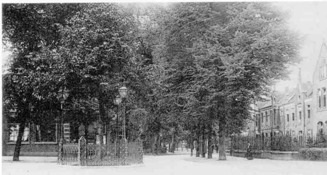
Het einde van de Groest, gezien vanaf het plein voor de Vituskkerk, zag er rond 1900 heel anders uit. In het midden de Wilhelminaboom met hekwerk. Rechts het St. Anna Gesticht met daarachter nog juist te zien het schuine dak van de boerderij van Kool, de buurman van Schuurmans (foto: Goois Museum).
