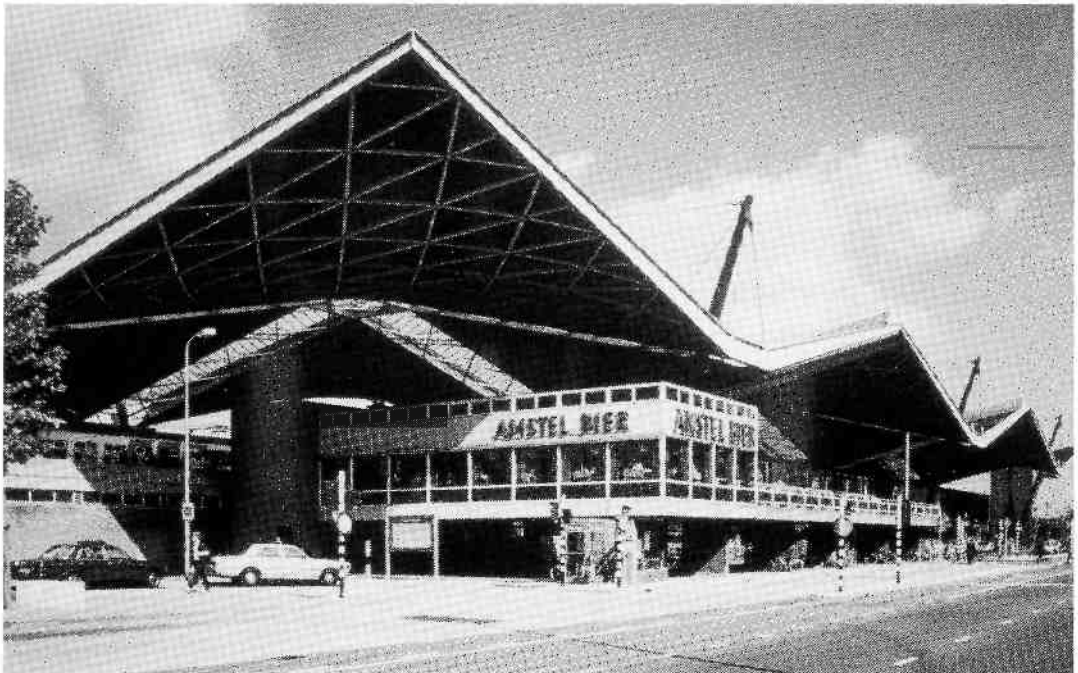
Het in de jaren '60 gebouwde station Tilburg weerspiegelt de paraplu-filosofie: een dak boven je hoofd maar verder beslist geen scheidsmuren.
