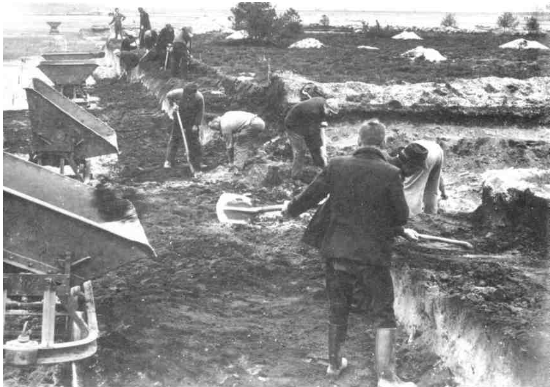
De aanleg van het Vliegveld Hilversum in de crisistijd vond plaats in het kader van de werkverschaffing.
