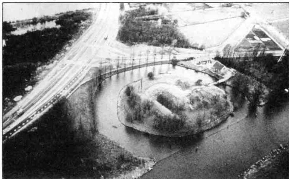
Luchtfoto (ca. 1975) van het fort Kijkuit tussen het Hilversums Kanaal en de Vreelandseweg.
