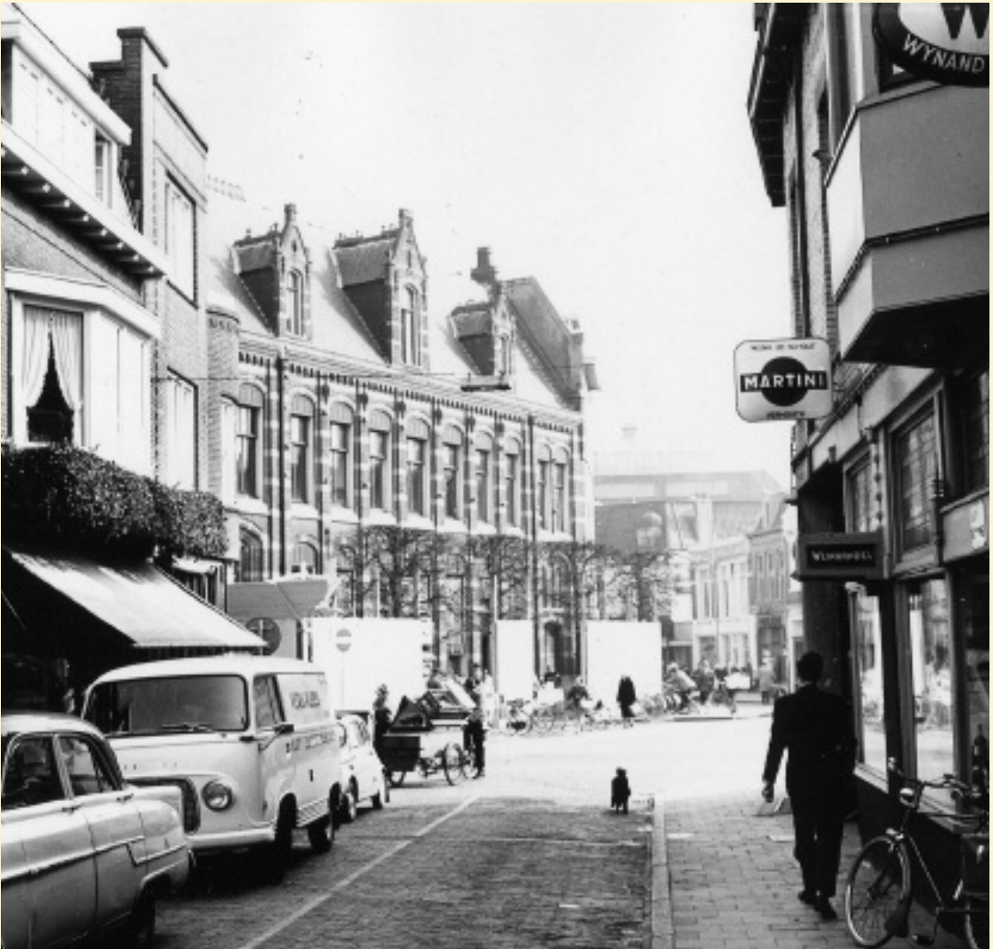
Het oude postkantoor werd in 1960 gesloopt om plaats te maken voor het C&A-filaal. Fotograaf M. Dop maakte een serie beelden van de afbraak. Deze foto is gemaakt vanuit de Schoutenstraat, toen nog een verkeersader.
